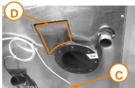
2.15. Enlever le capteur de température des gaz de combustion (C) pour accéder plus facilement à la sonde Lambda (derrière l'isolation de la chaudière (D))
