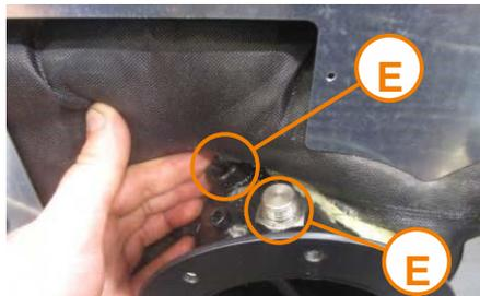
2.16. Retirer l'isolation de la chaudière (D) et retirer le bouchon de la sonde Lambda (F) (E)
